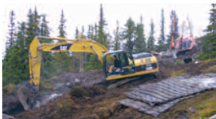
Det graves grøfter for utvidelse av snøanlegget i Natten Alpinsenter; Johnny Nybråten kjører den nye 323D.
