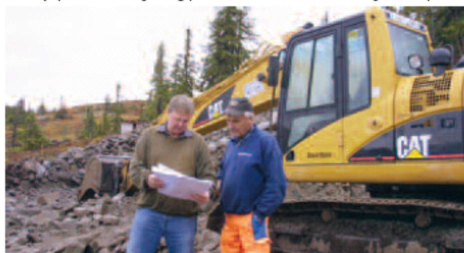
Grunneier og byggherre Knut Tandberg (t.v.) og Bernt Stuvebakken studerer tegningene for tomtene som nå opparbeides.
